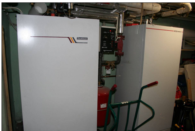
Ny luftvärmepumpenläggning
