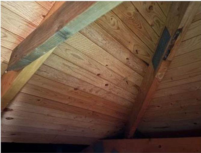
Mikrobiell påväxtnockvind (huvudbyggnad).
