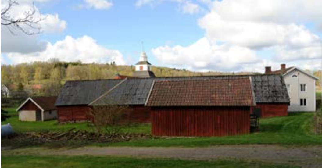
Nära inpå kyrkan ligger flera gamla gårdar. Här Hornagården med ekonomibyggnadernas gavlar vända in mot den obebyggda bymarken som ännu betas.
