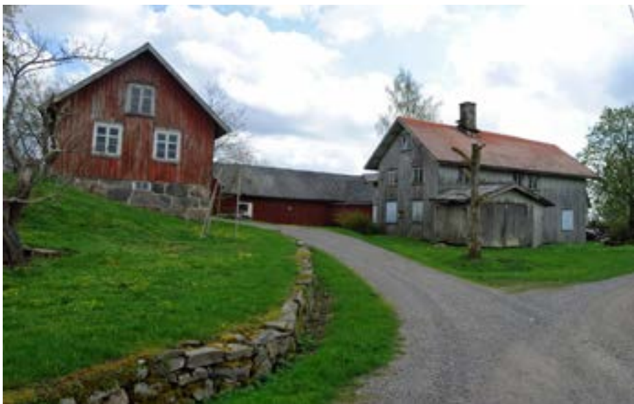
Äldre gårdsbebyggelse vid Storagården. Den gamla manbyggnaden står tom sedan flera år.
