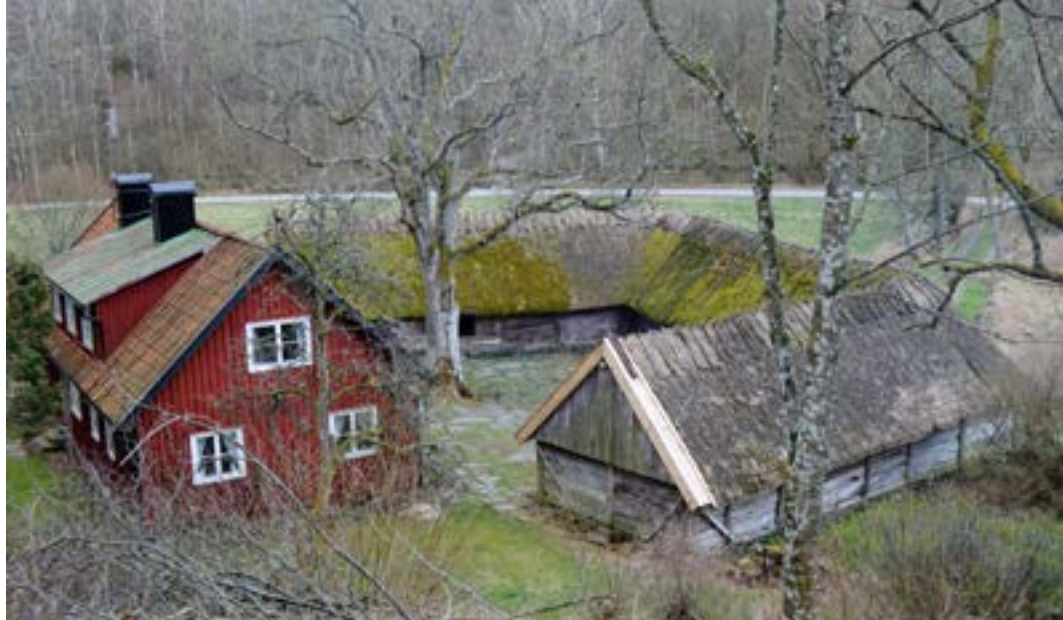
Ladugården blev Hallands första byggnadsminne 1963. Den i princip komplett bevarade trelängade ekonomibyggnaden från början av 1700-talet är unik genom sin storlek och ålder.
