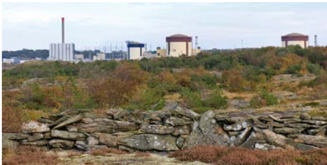
Ringhals kärnkraftverk är uppfört omedelbart intill Biskopshagens karga hällmarker, vilka idag till stor del utgör naturreservat.
