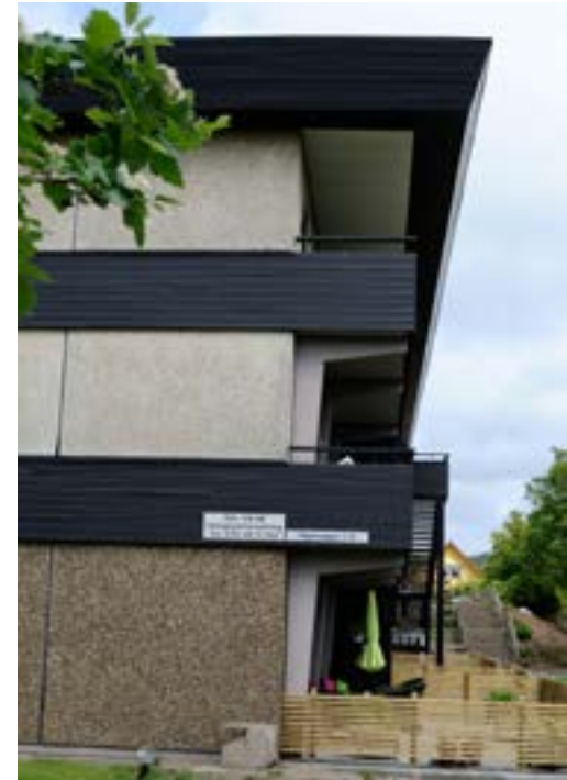
Det utskjutande taket med sin karakteristiska spetsiga profil fungerar som skydd över loftgångarna.
