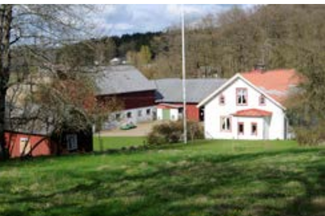
Svennagårds man- och ekonomibyggnader sedda från sluttningen i norr.
