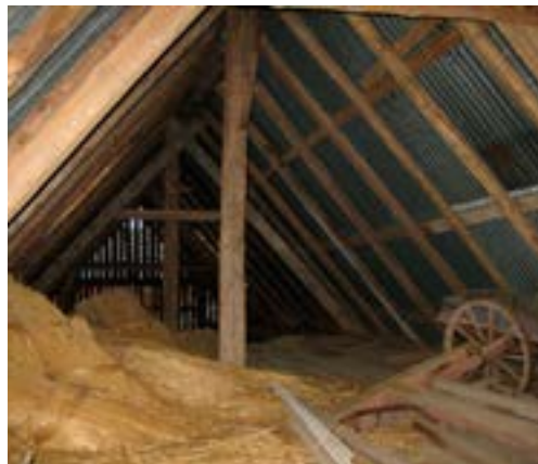
Takkonstruktion med mesulor i den kringbyggda gården mitt i Svenstorp.
