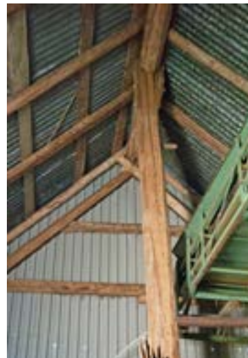
Ladugårdens tak bärs upp av mesolor och är länets yngsta exempel på en sådan konstruktion.
