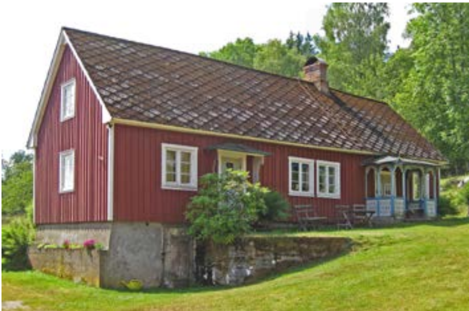
Manbyggnaden på Vik 1:3. Notera bl.a. de två entrépartierna och de tätt sittande fönstren. Källardelen har tillkommit i mitten av 1900-talet.
