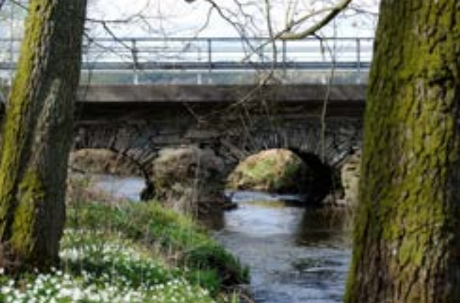
Den gamla stenvalvsbron över Skuttran strax nordost om Svennagård.
