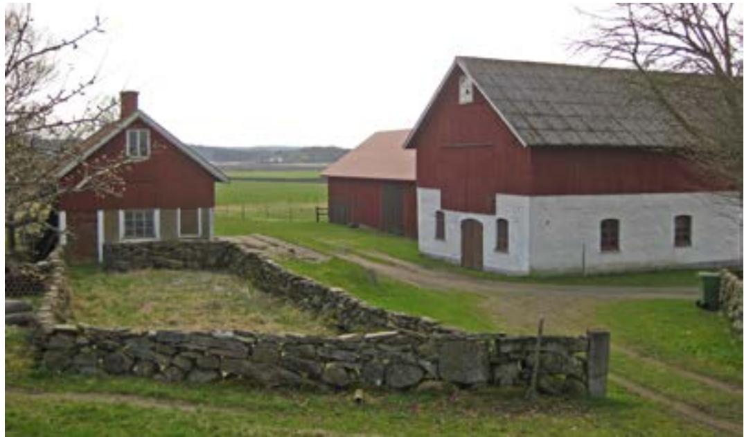
Ekonomibyggnader från slutet av 1800-talet. Svinhus (tv) och ladugård med bottenvåning i gjutteknik. Årnäs 2:3, Ås socken.
