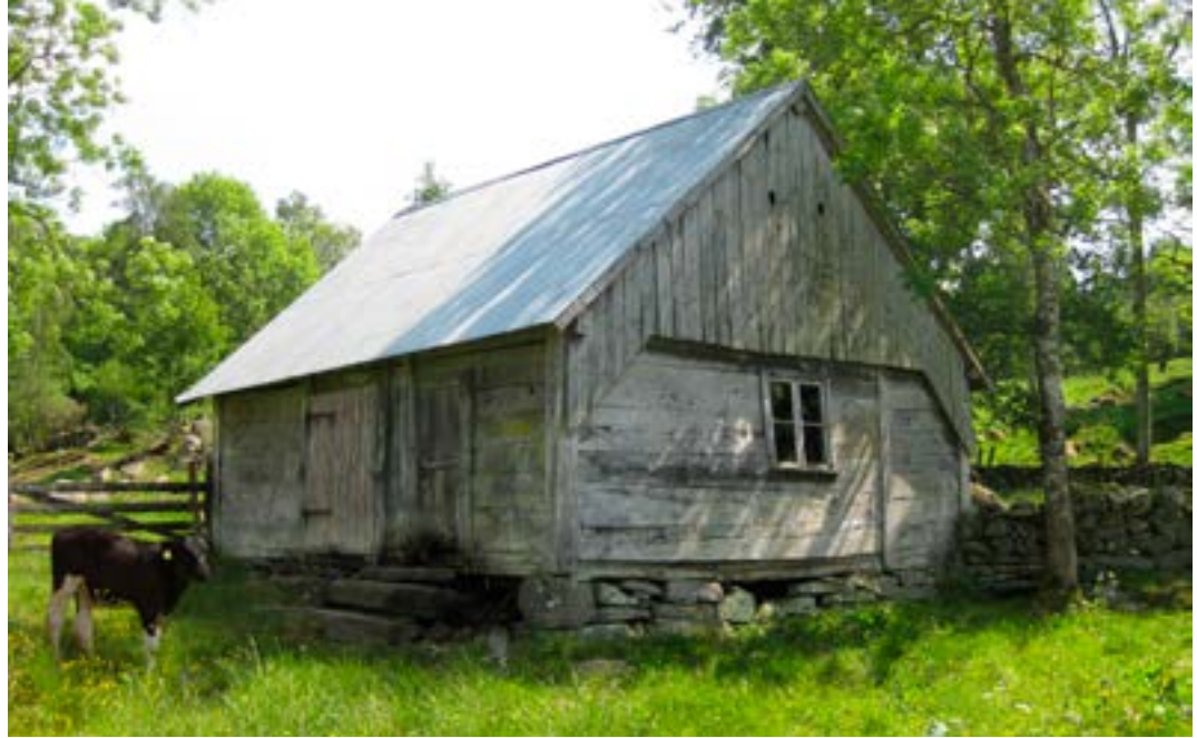
Ålderdomlig s. k. dubbelbod i skiftesverk vid Holmåkra.
