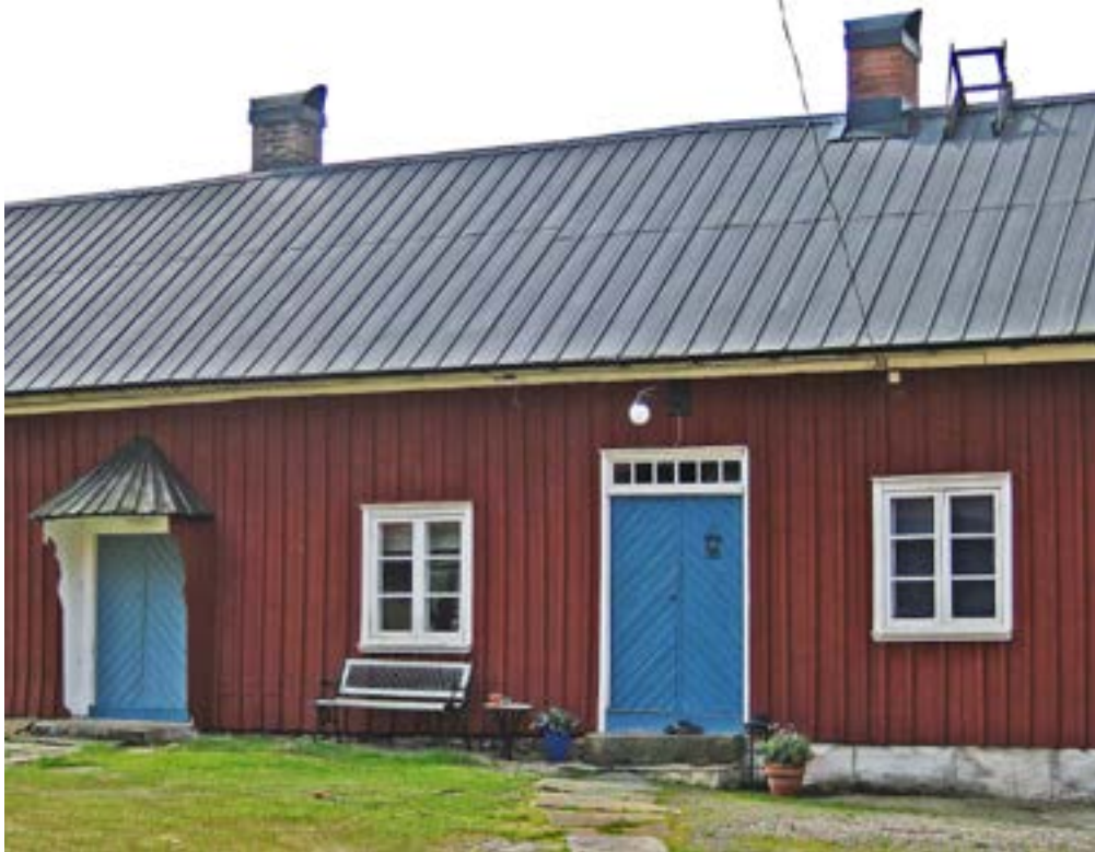
Del av manbyggnadens fasad mot innergården. Till vänster ett s.k. bislag med figursågade sidostycken och halvcirkelformat brädtak. Till höger huvudentréns pardörrar med överljus. Taket är täckt med pannplåt.
