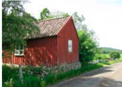
Den gamla bysmedjan ligger utmed Holmåkravägen en bit utanför bykärnan.
