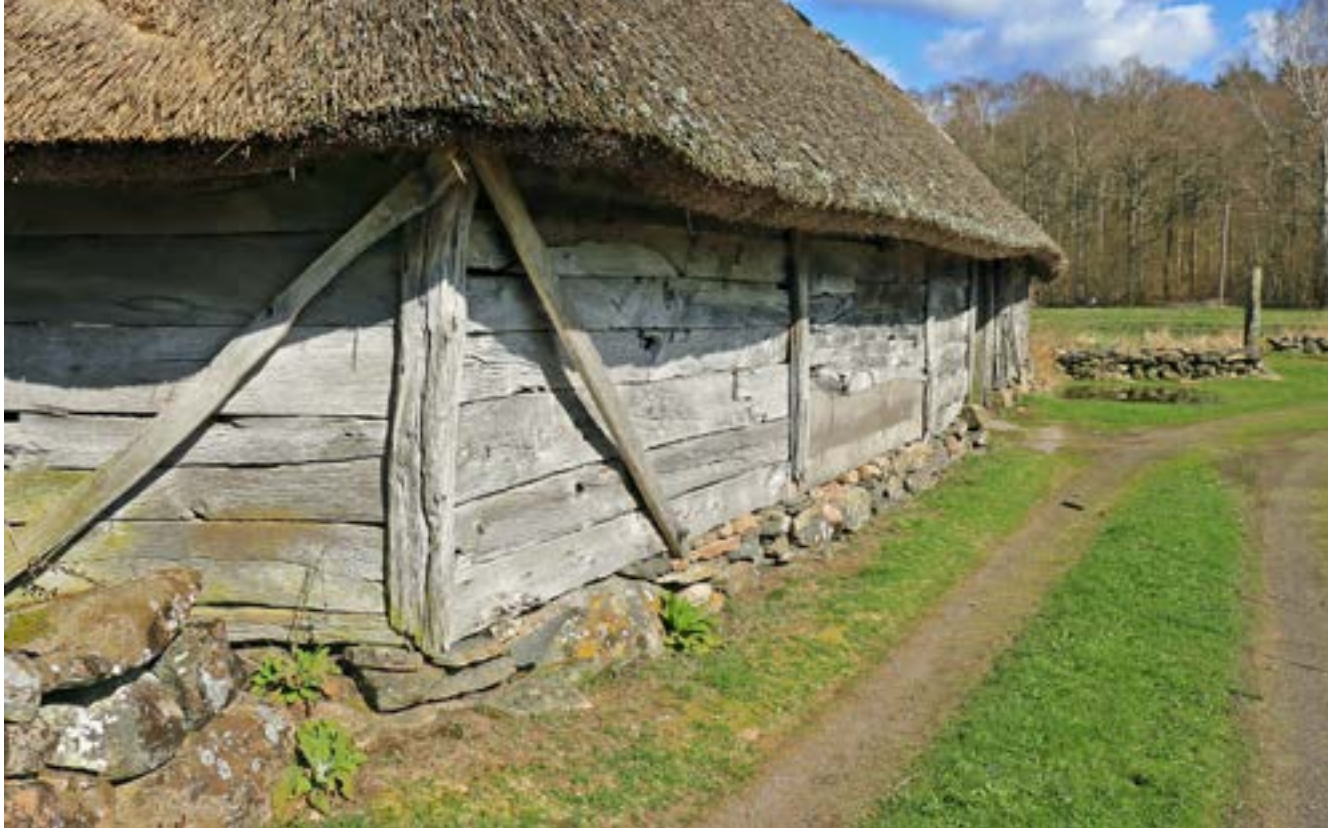
Åkrabergs ladugård. Den gamla vägen passerade alldeles intill den södra längan, här sedd från sydväst.
