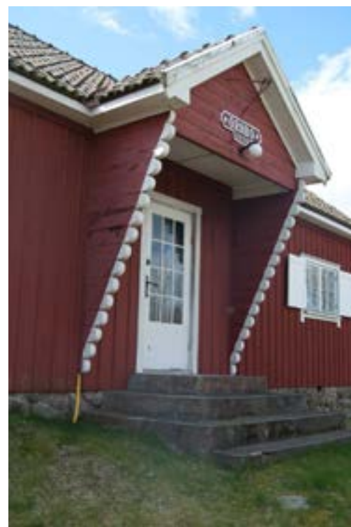
Stugan med det passande namnet Örnbö har en stilfull entré mot Kärra bygata.
