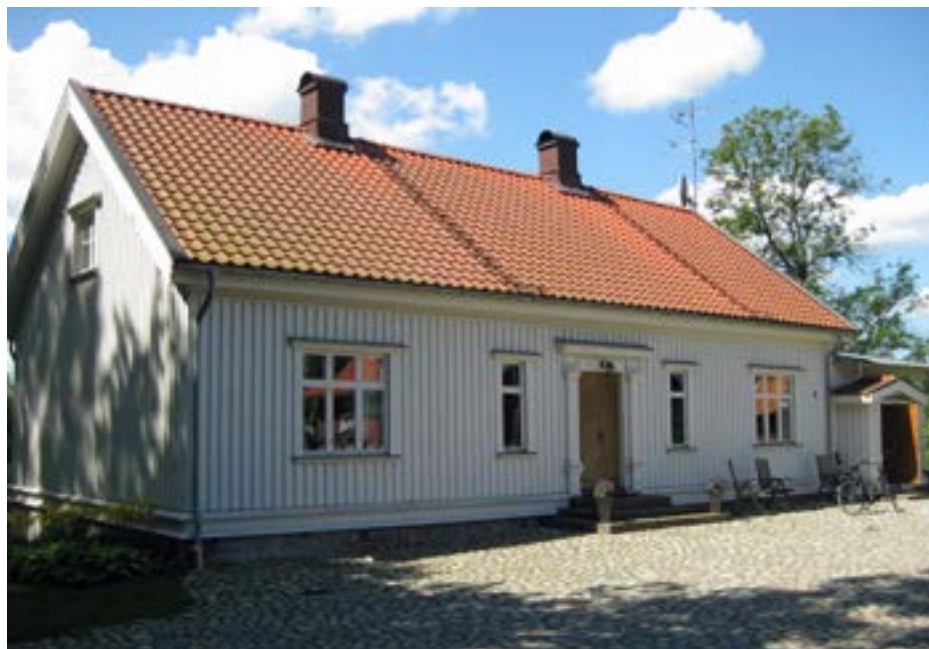
Huvudbyggnadens fasad mot den stenlagda gårdsplanen.
