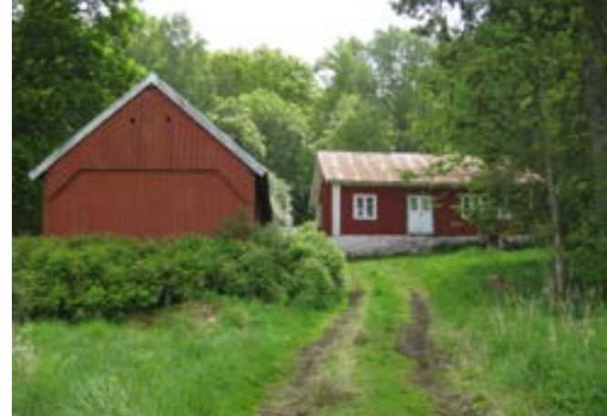
Torpet vid Sannagård 1:4 började bebyggas 1896.
