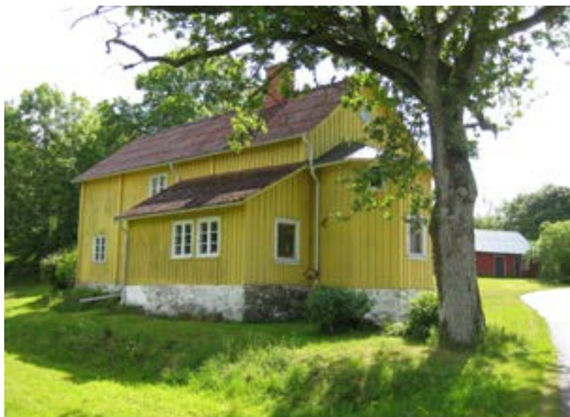
Storegårdens baksida. Notera de kraftiga grundmurarna. De utskjutande delarna innehåller trapphus och kök och har troligen tillkommit under senare delen av 1800-talet.
